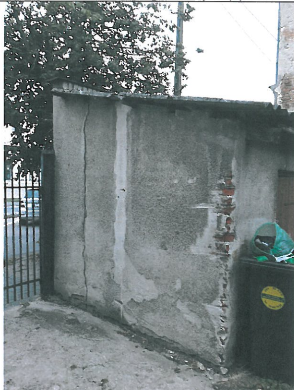
Zdjęcie nr 4 – Ściana oddzielenia ppoż. w sąsiednim budynku gospodarczym (3)
